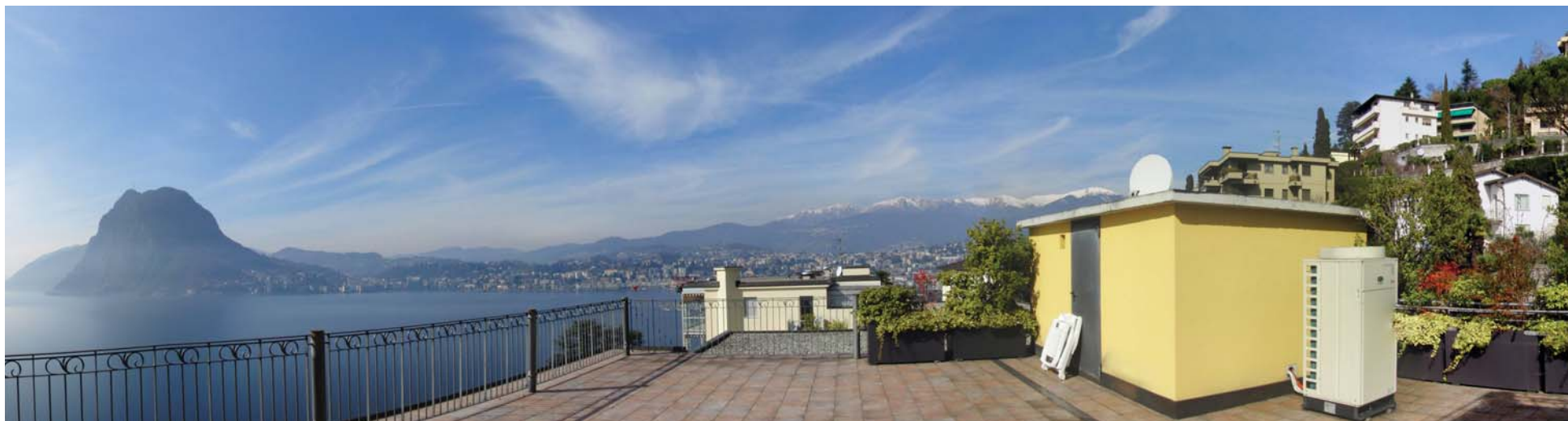
TERRAZZA AL 6° PIANO - 6° FLOOR TERRACE
